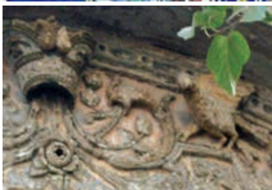
تصویر ۲- تهران، خیابان کارگر جنوبی، چهارراه لشگر، ابتدای خیابان کمالی، ماخذ تصویر: همان، بهار ۸۶
